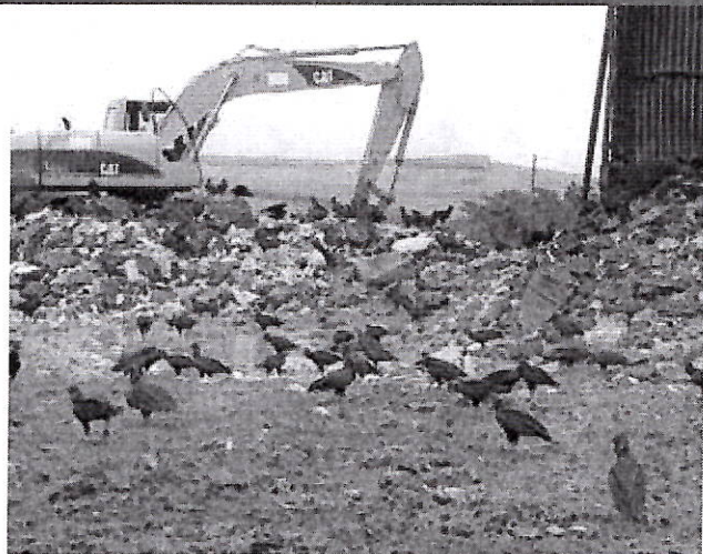
Foto 1 - Estação de Transbordo de Amparo.
