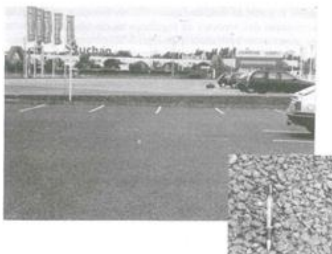
Figura 92: Utilização de pavimento poroso em estacionamento.
